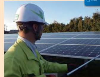
モジュールのセルラインを確認し、断線状態を検査します。故障部位の特定も可能です。
